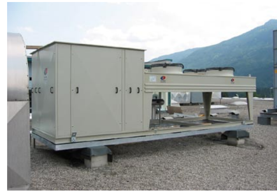
Flüssigkeitskühlsatz der KWN Engineering-Gesellschaft (indirekte Anlage, Kältemittel „schick R723“, Kälteleistung 230 kW, Hauptkomponenten zwei Hubkolbenverdichter mit luftgekühltem Verflüssiger)
